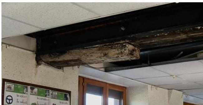
Une poutre centrale s'affaissait dans l'une des classes. Photo Solange Bocchio
